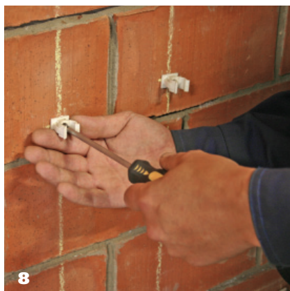
8 Устанавливаются подвижные опоры
