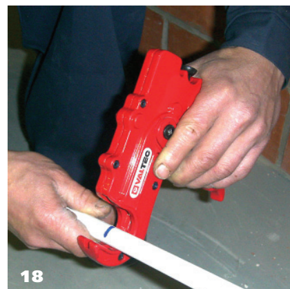
Отрезается требуемый кусок трубы. Это можно делать с помощью гильотинного трубореза в следующем порядке: –труба помещается в опорную скобу трубореза;
