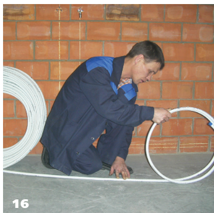
Вручную распрямляется отмотанный участок трубы
