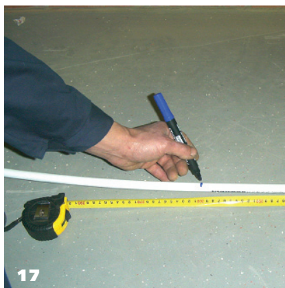
С помощью рулетки отмеряется точное количество трубы и делается метка фломастером
