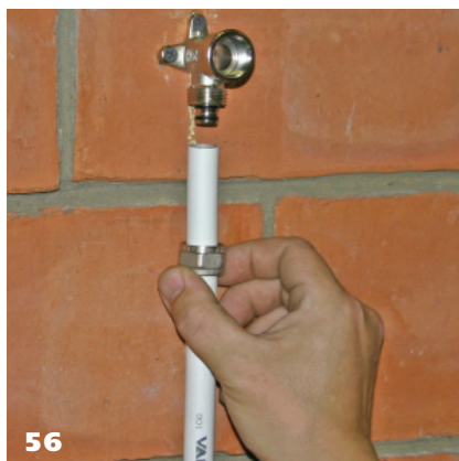
До надевания трубы на штуцер, на трубу надевается накидная гайка
