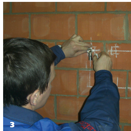
3 Намечаются места установки водорозеток
