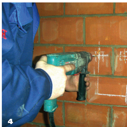
4 Высверливаются гнезда для крепления опор и водорозеток
