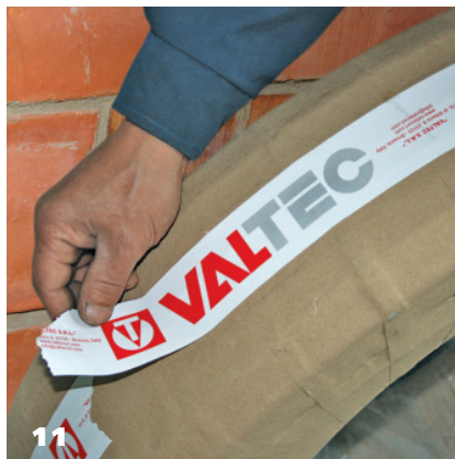
С упакованной бухты трубы снимается радиальный упаковочный скотч с логотипом фирмы-изготовителя
