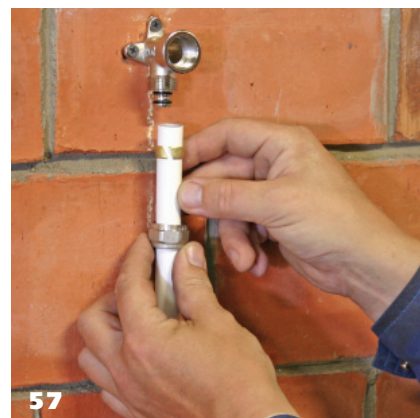
Затем на трубу надевается «сухарь»
