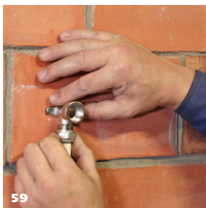
Сухарь и гайка придвигаются к корпусу фитинга. Накидная гайка заворачивается вручную до тех пор, пока пальцы не начнут проскальзывать
