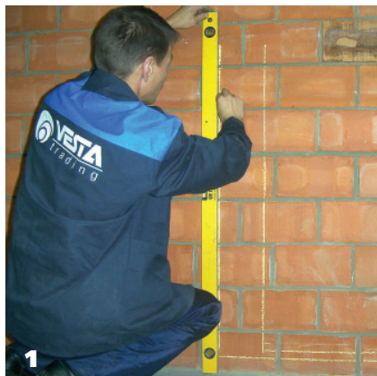
1 Разметка трассы трубопровода
