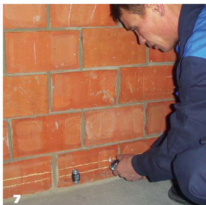
7 Устанавливаются неподвижные опоры
